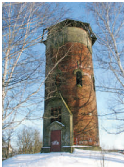
Хотьково. Водонапорная башня
